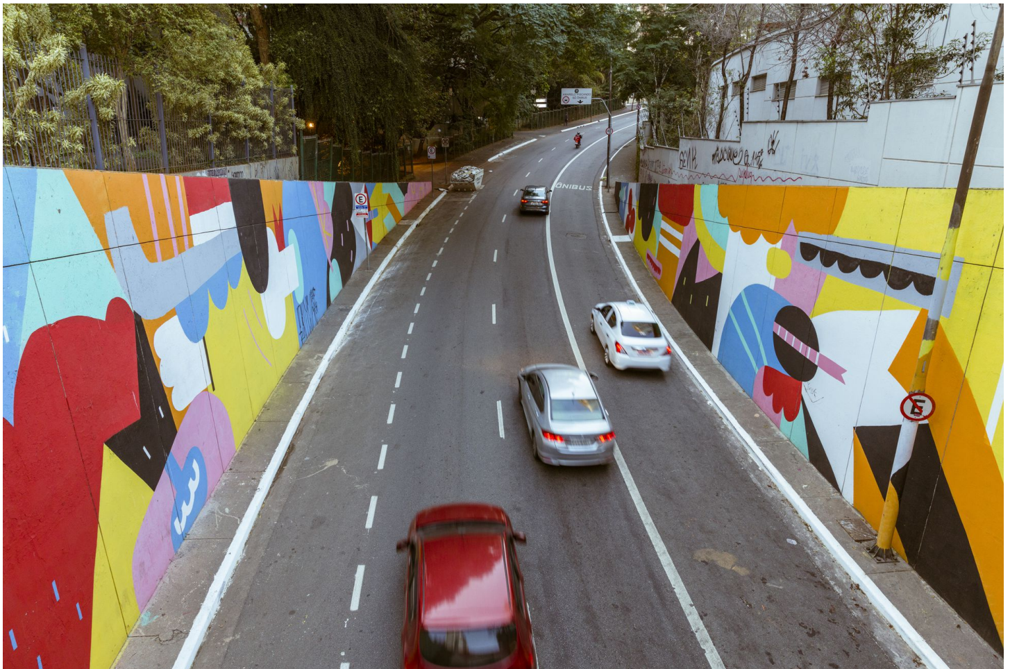
La entrada de un túnel, pintada por Loro Verz. GUI CHRIST
